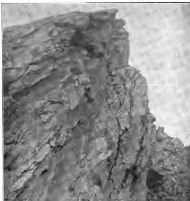
Fig. 279. — Paroi rocheuse verticale en voie d'émiettement. Face au Morne de Macouba.
